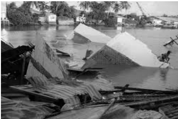
Hình 3.13- Mưa lớn gây sạt lở, sập đổ các công trình, nhà ở Yên Bái, chết 33 người.
