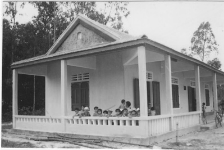
Hình 4.16. Mô hình nhà thử nghiệm chống thiên tai nứt đất (Nhà mẫu giáo Độ Xá 2, Hoàng Tân, Chí Linh, Hải Dương).
